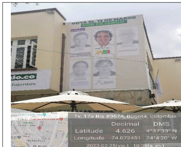
Elemento identificado sobre la CL 36, instalado en antepecho superior al segundo piso.
